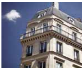
◀ Le 3 e immeuble à Paris, quartier Saint-Lazare. Propriété d'Afer Immo sci
